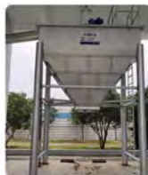
泥饼输送及存储
